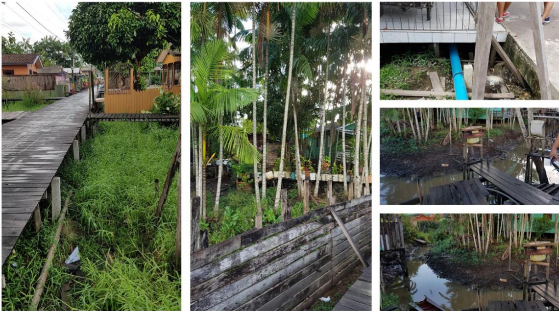
Figura 2. Déficit de infraestrutura na cidade de Afuá, Pará, Brasil (Fonte: Laboratório de Estudo das Cidades Coleção/UNIVAP) .
