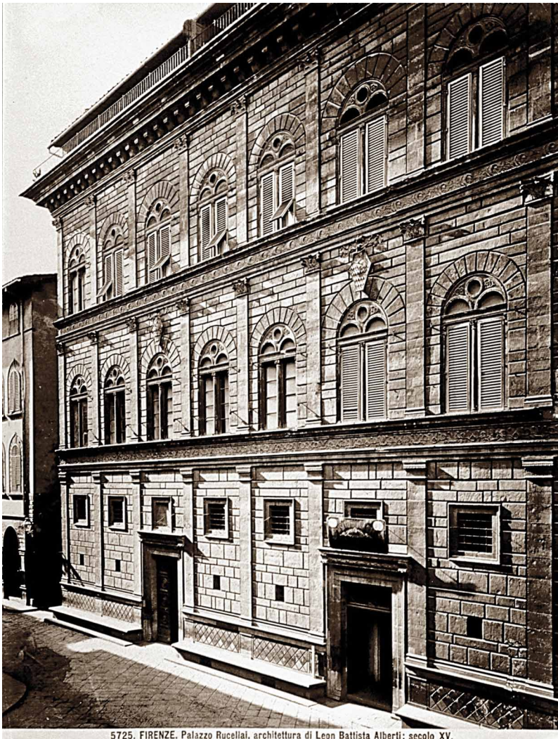
5725. FIRENZE. Palazzo Rucellai, architettura di Leon Battista Alberti; secolo XV.
