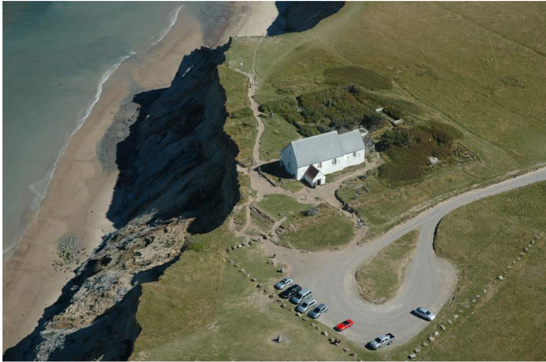
Figure 1. Mårup church, in Lønstrup Klint
